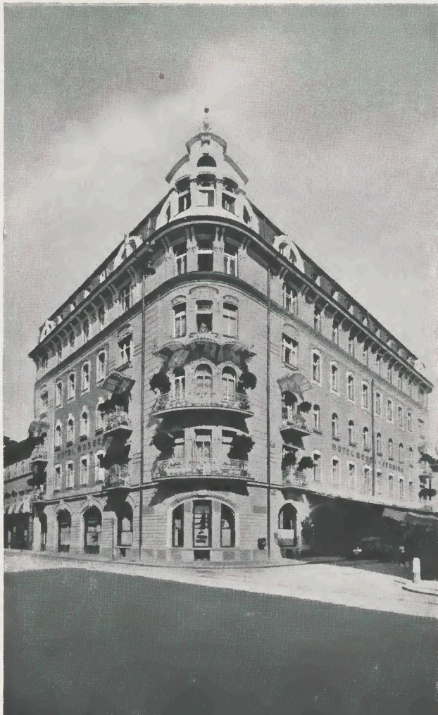
Ausbau des Hotels Moser-Berdino in Klagenfurt (2 Geschosse) unter Verwendung von 3000 m 2 Heraklithplatten
