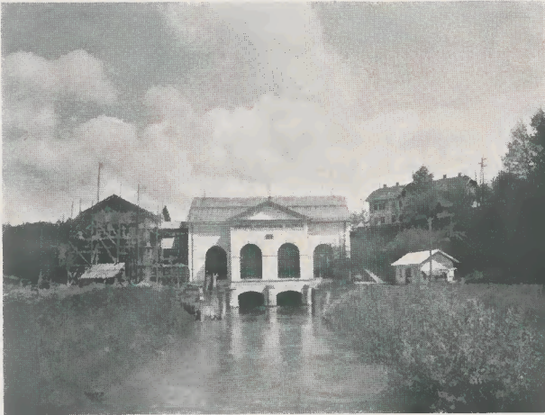
Maschinenhaus mit dem neuen Schalt haus
