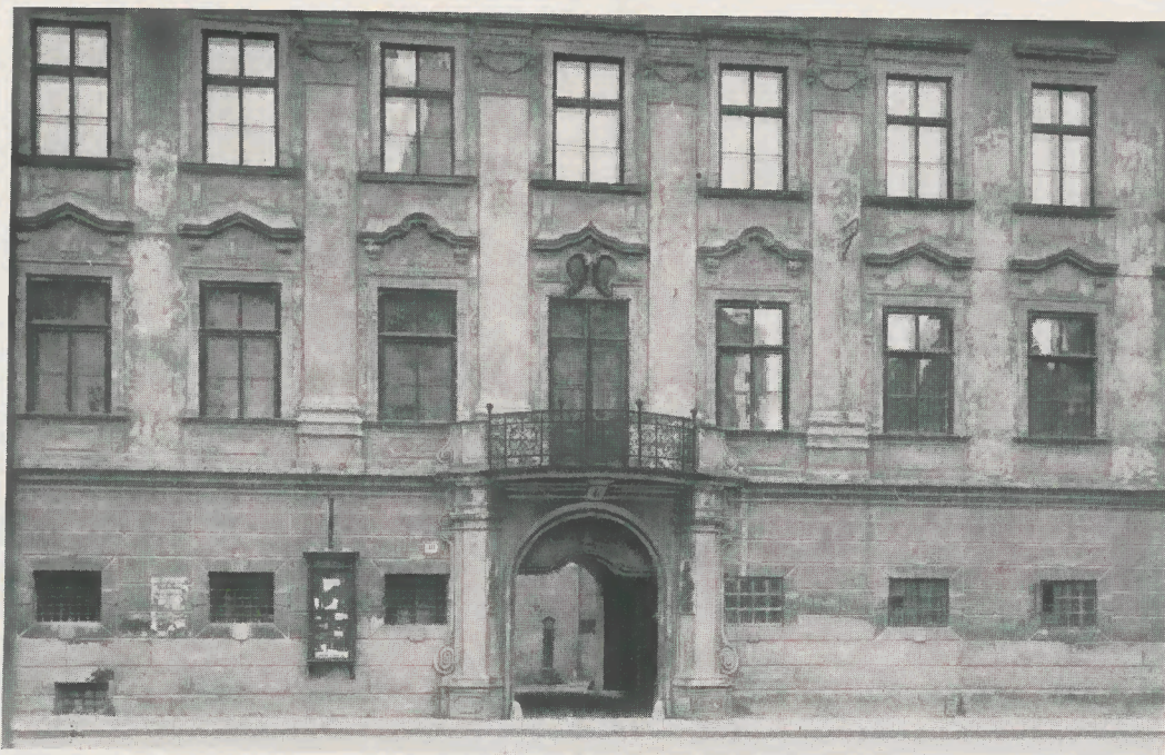
Fassade des Goëtz-Palais am Alten Platz (Ausschnitt)
