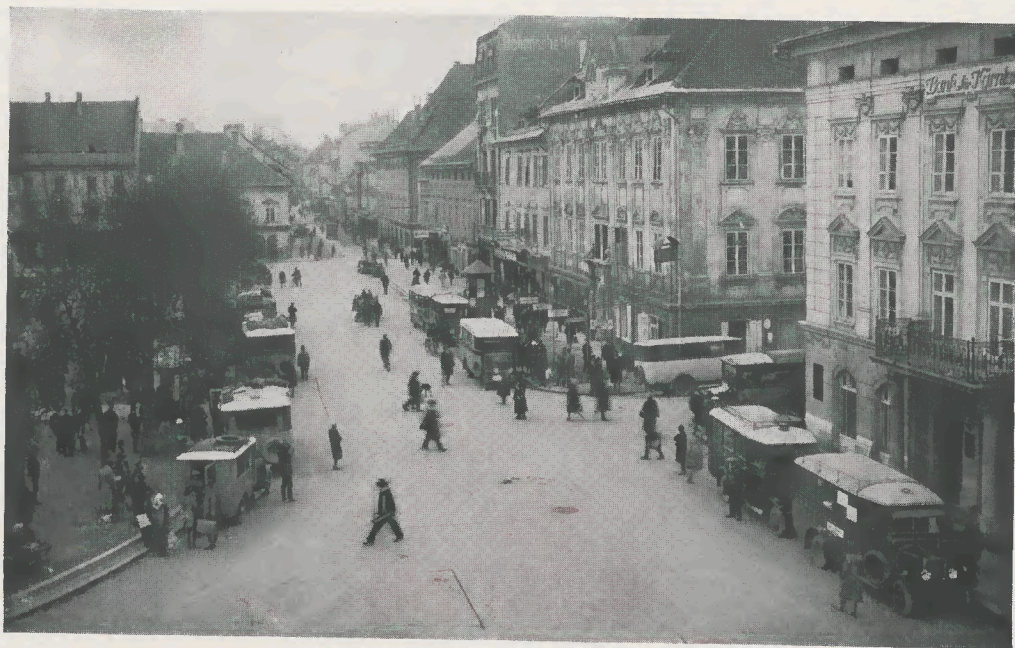
Autobahnhof am Neuen Platz
