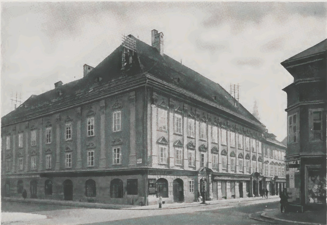
Der „Bittringerhof“ an der Ecke Neuer Platz-Kaserngasse
