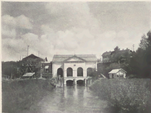
Maschinenhaus mit dem neuen Schalthaus
