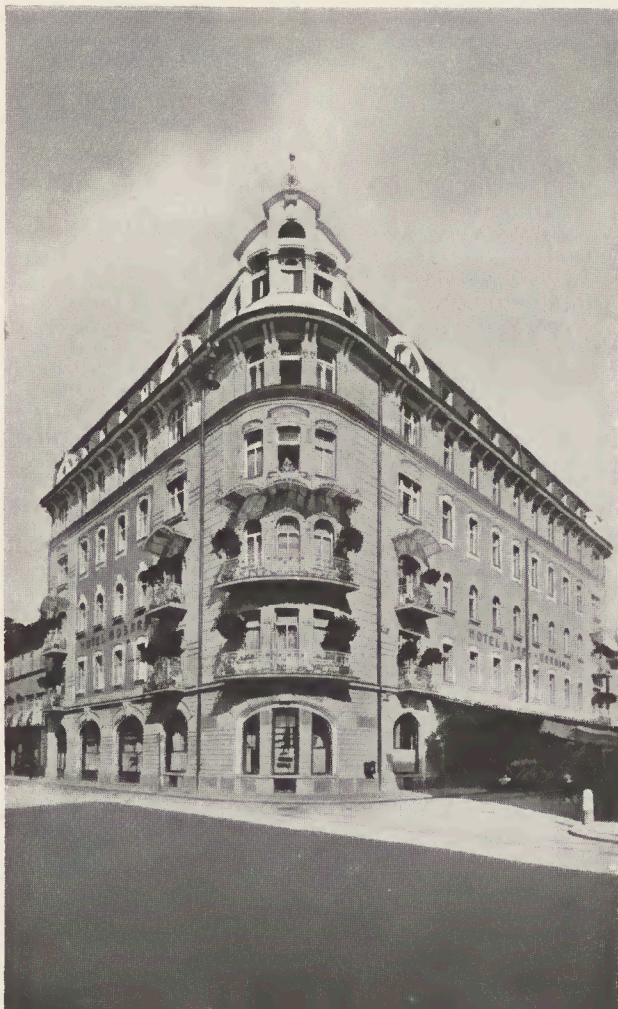
Ausbau des Hotels Moser-Berdino in Klagenfurt (2 Geschosse) unter Verwendung von 3000 m 2 Heraklithplatten
