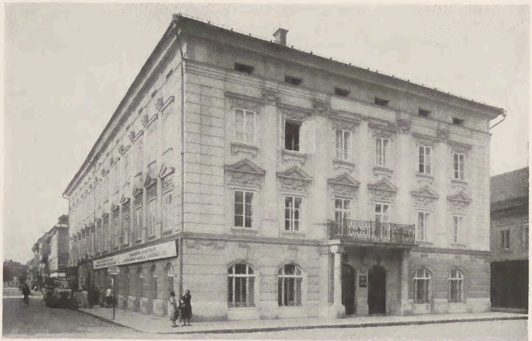
Sparcassengebäude Neuer Platz Nr. 14
