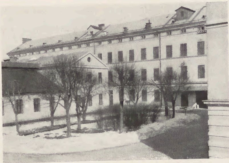
2. Fabrikationsgebäude, vorne das Rauchtabakfabrikationsgebäude
