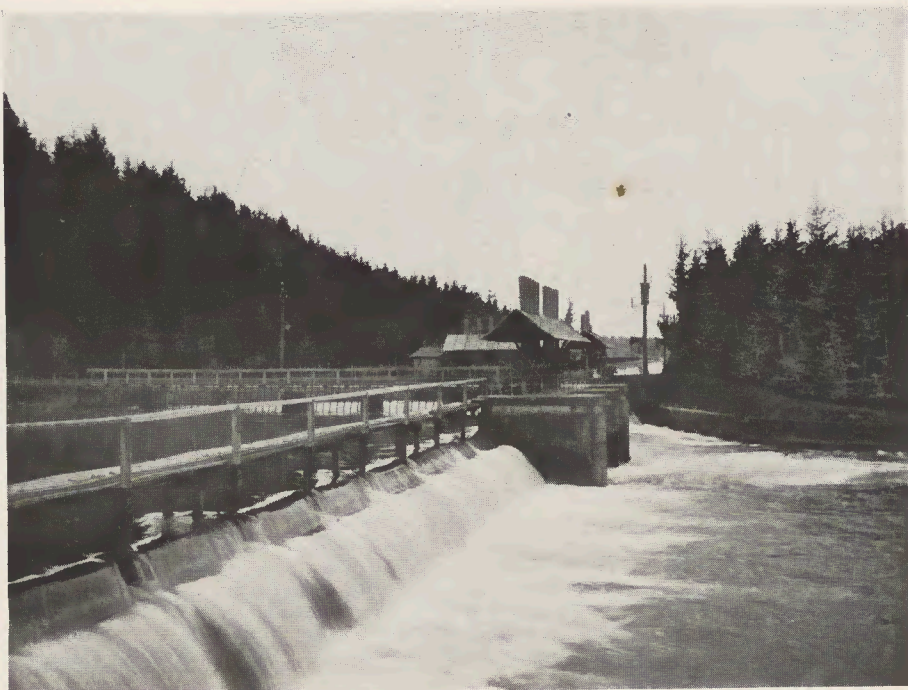
Wehranlage am Gurkfluß
