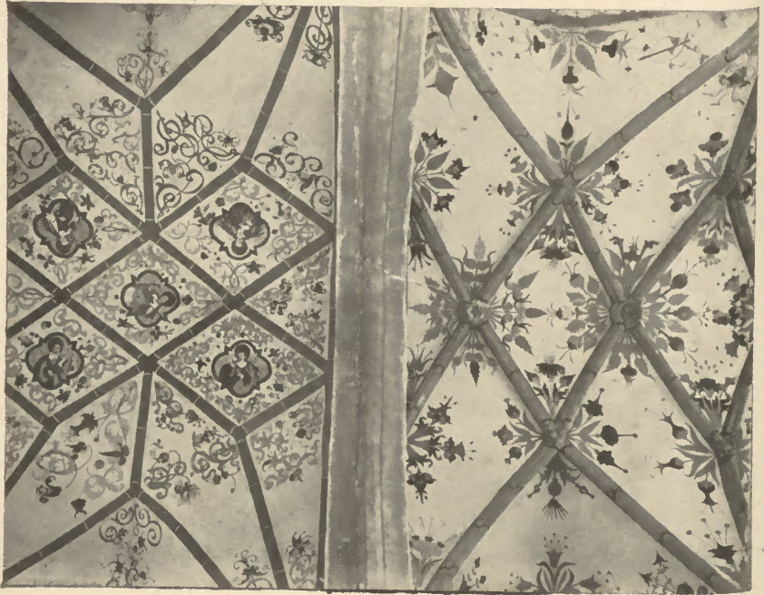
21. Grades, St. Wolfgang, Gewölbe
