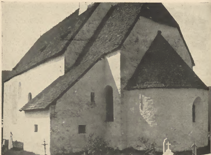
101. Zweinitz, Pfarrkirche von Südosten
