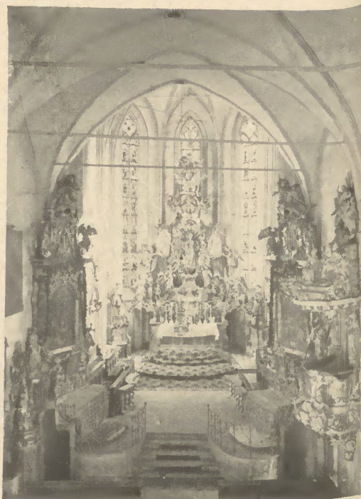
143. Lieding, Pfarrkirche, Innenansicht
