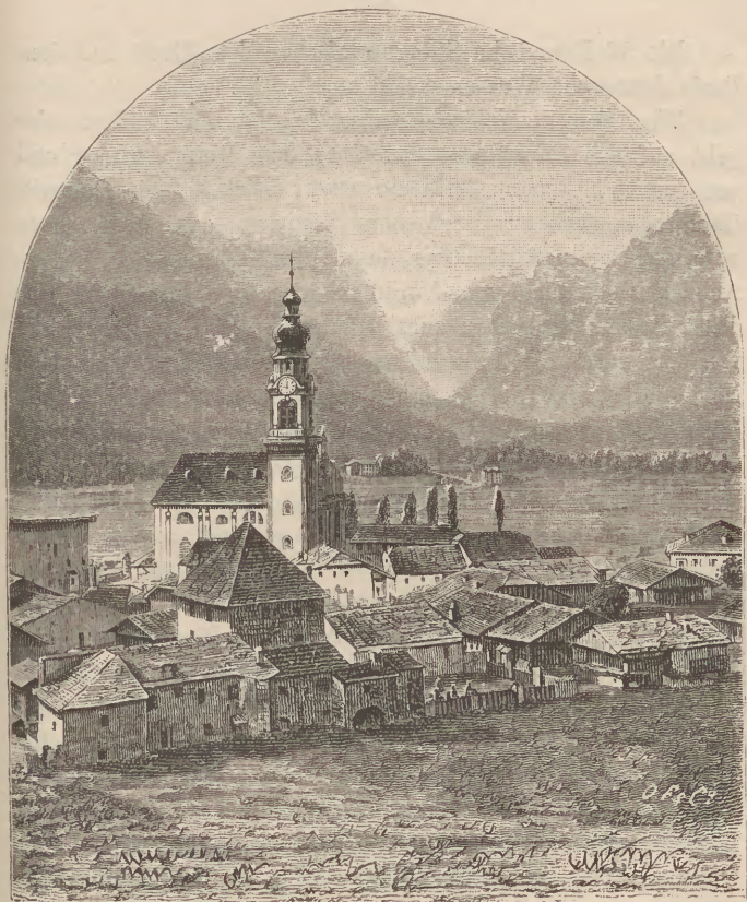
Toblach, Eingang in's Ampezzaner-Thal.
