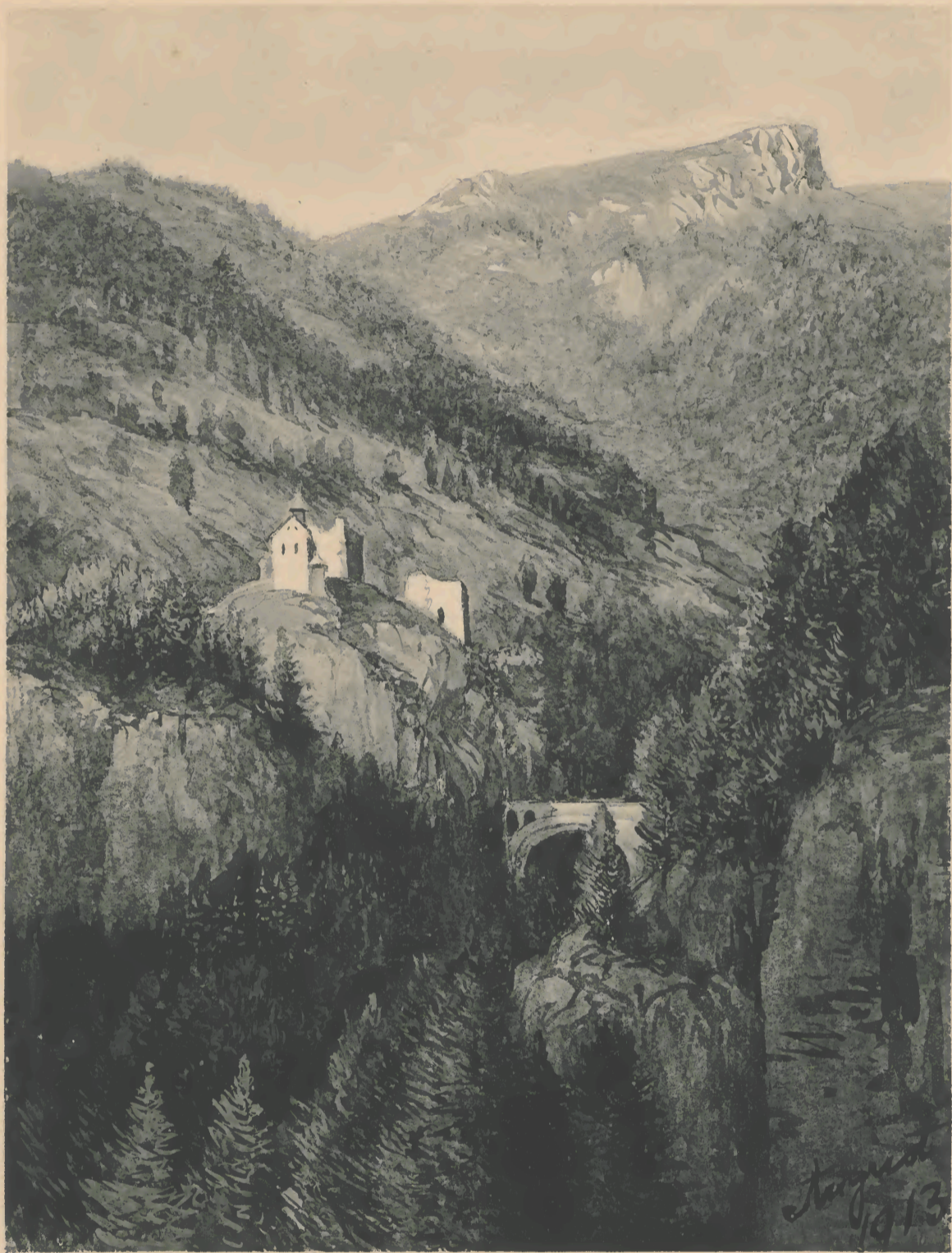
Ruine Ober-Falkenstein und Viadukt auf der Tauernbahn bei Oberbellach.
